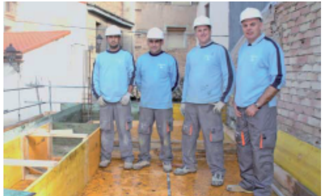
Aparicio junto a tres de sus trabajadores en una de sus obras
